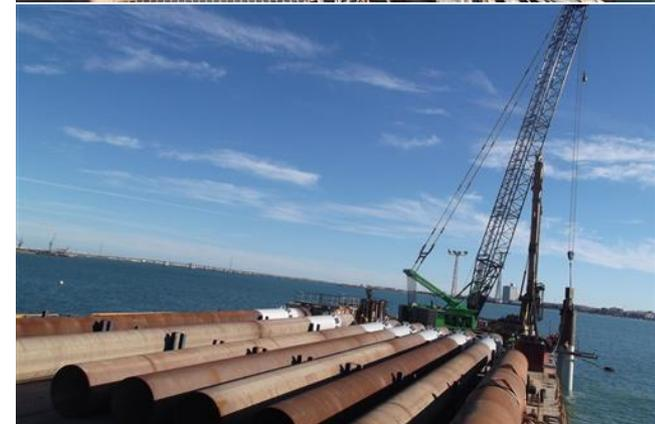
**Obra:** Explanada y viga pilotada en la Fase B del muelle de isla Verde exterior 342-B, Bahía de Algeciras, CADIZ 45469
